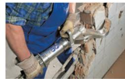
Гидравлические ножницы HCS8 J способны разрушать бетонные стены толщиной до 15 см (зависит от прочности бетона), что является неоспоримым достоинством при выполнении демонтажа стен, фасадов или ремонта желеобетонных панелей.
